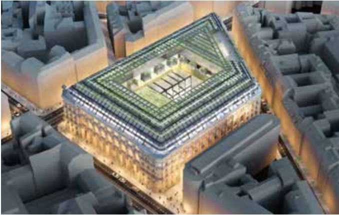
Poste du Louvre - France - Clima Canal
