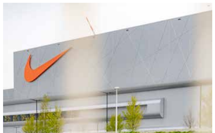
Nike Distributiecentrum - Belgium - AVS Unit heater EC
