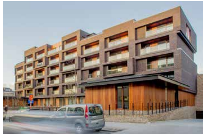
Clarenhof Woonzorgcentrum - Belgium - Mini Canal
